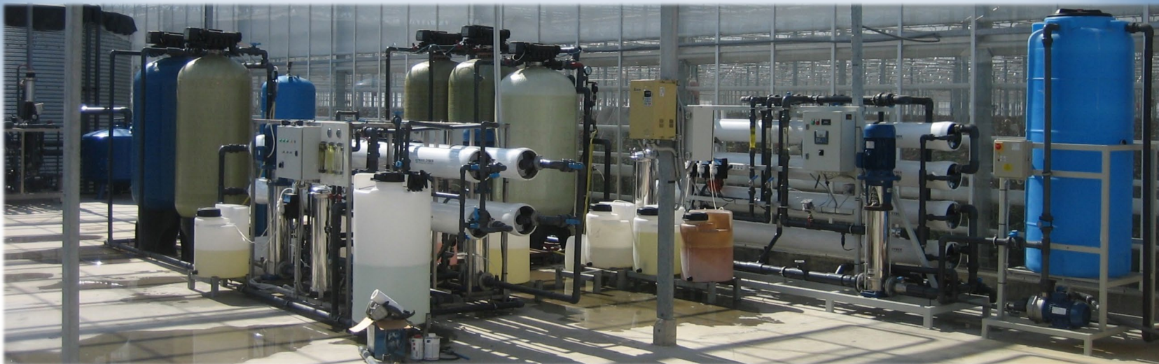
Установка обессоливания воды для тепличного комбината «Мосроза» (сверху)
