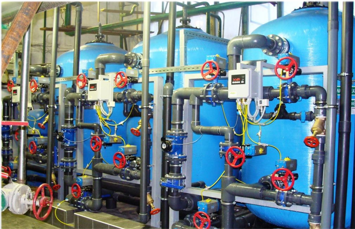
Станция ионообменного удаления солей жесткости для паровой котельной ОАО «Вимм Билл Данн», 120 м 3 / час
