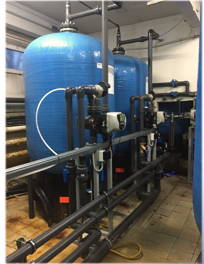
Установка очистки воды для линии розлива на Старо- Мытищенском источнике
